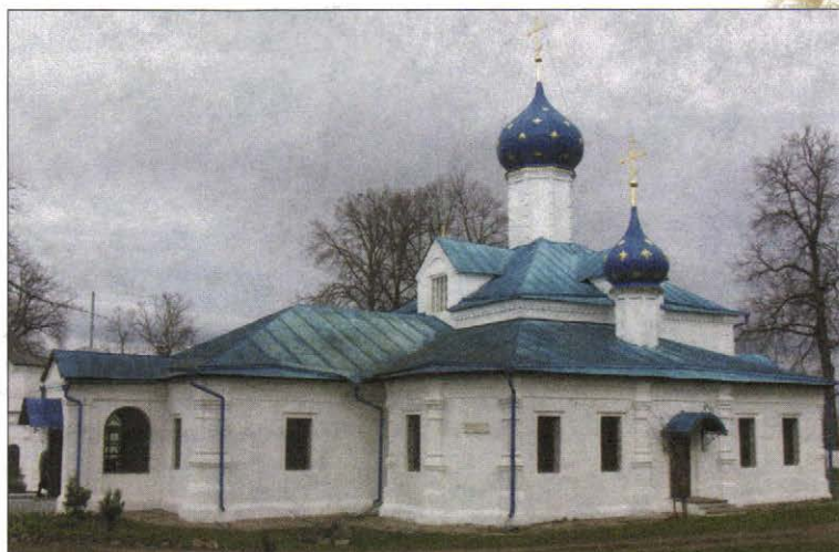
Введенская церковь Фёдоровского монастыря в Переславле- Залесском (XVIII в.)
